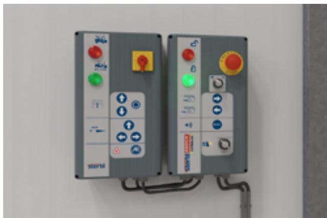
Le voyant du panneau de commande COMBILOK® G<sup>2</sup> passe au vert et signale que le véhicule a bien été sécurisé par le G<sup>2</sup>. Le feu de circulation extérieur, quant à lui, devient rouge, indiquant que le niveleur est en position et que le chargement ou le déchargement peut commencer en toute sécurité.
