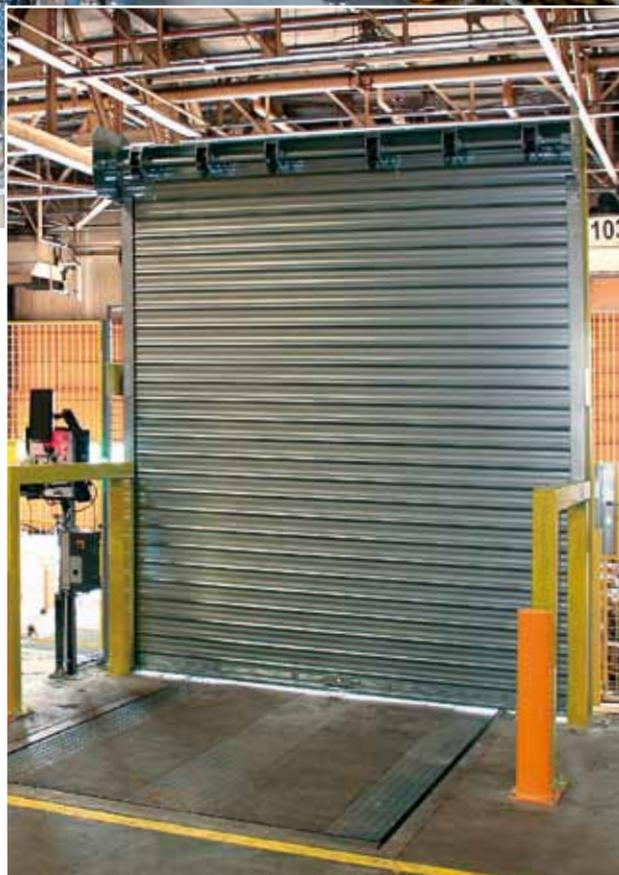
Les rails latéraux (coulisses) existent également en de nombreuses exécutions suivant la dimension du rideau, la résistance au vent et les conditions d'implantation.
